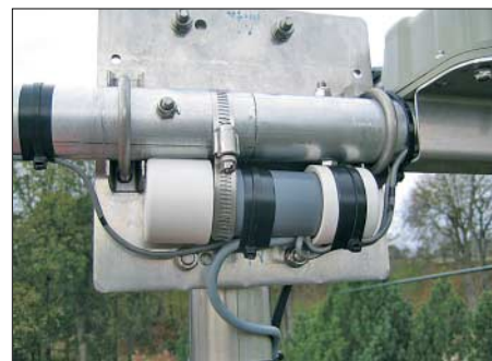
Bild 13: ... fertig montierten Kabelgehäuserohr an der Boomplatte ziehen Fotos: DC9AT
