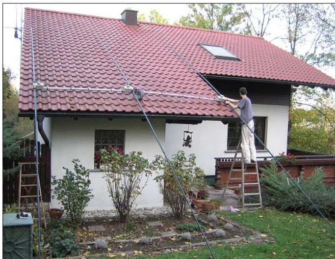
Bild 1: Die fertige Antenne vorm Aufstieg zum Mast
