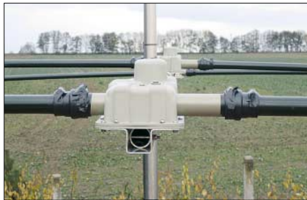
Bild 16: Eingesetzte Elemente mit zusätzlich unwickelten Muffen
